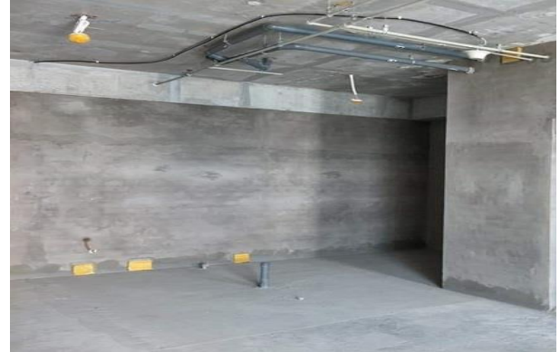
Thi công hoàn thiện
