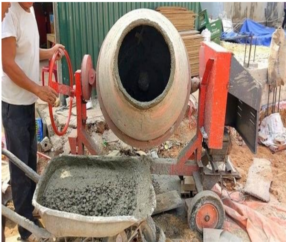
Trộn bê tông bằng máy
