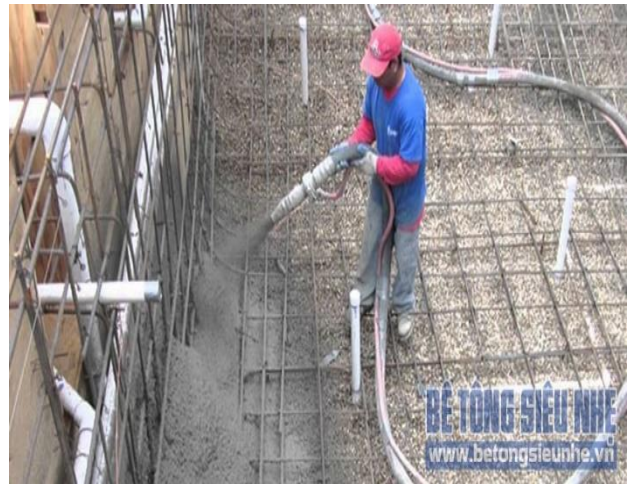
Công nghệ phun bê tông
