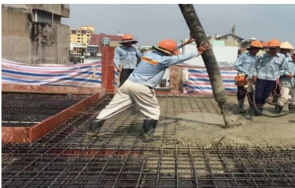
Thi công bê tông
