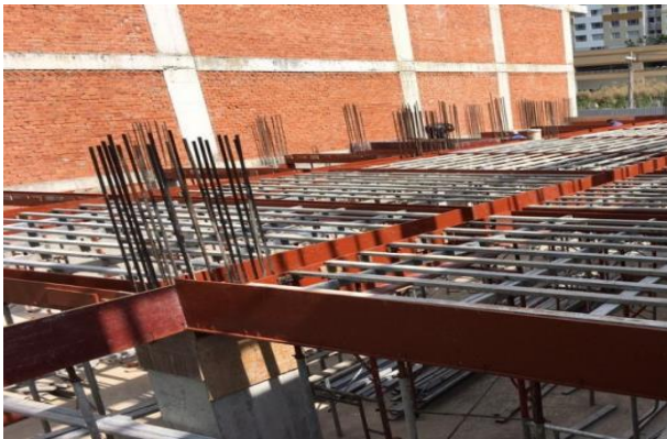
Thi công ván khuôn, giàn giáo
